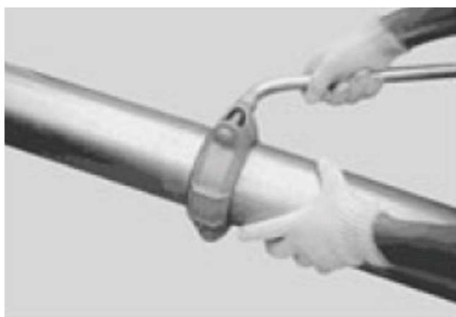
⑥ 本体の爪部は配管溝に正確にセットされたことを確認してボルトを相互に締付ける
