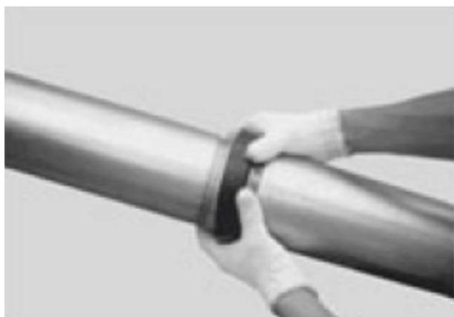
④ ゴムリングは両端配管溝の間になるように反対側の配管も同様にセットする
